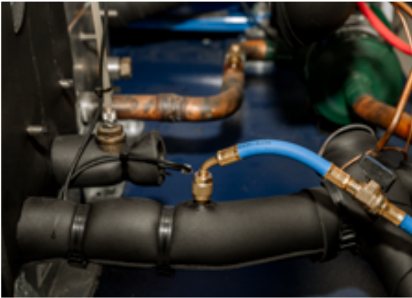
Priključna crijeva s kuglastim ventilima za brzo zatvaranje i otvaranje protoka rashladnog plina
